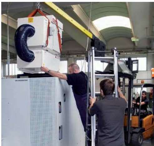
Fase d'installazione di un nuovo impianto AR su una macchina utensile nell'officina OMZ.
